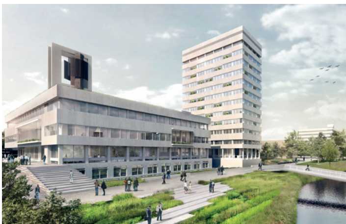
IMPULS renoveert zeven gemeentelijke panden in Eindhoven slim en duurzaam.
